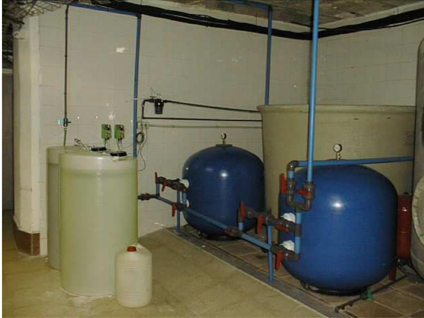
**Figura 1.11.** Vista general de algunos elementos del sistema de reutilización. El depósito de recirculación, los filtros de arena, los bidones y los dosificadores de hipoclorito de sodio. También se aprecia el color azul que distingue las tuberías que conducen agua gris de las que conducen agua potable, de color negro.
