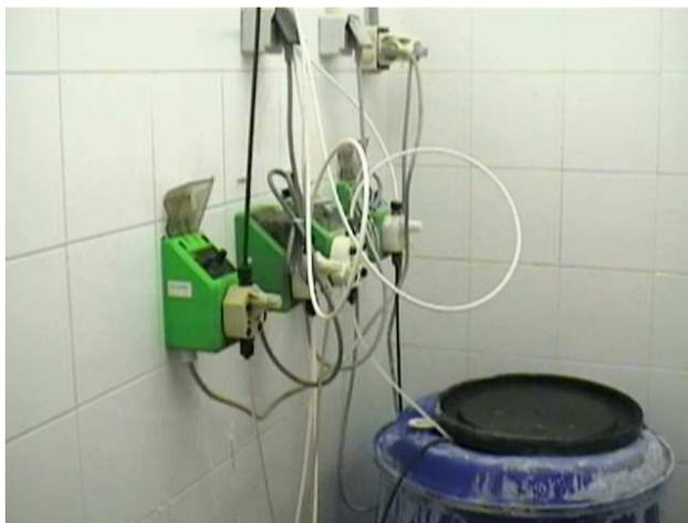
**Figura 1.15.** El dosificador y el bidón de hipoclorito de la segunda cloración.
