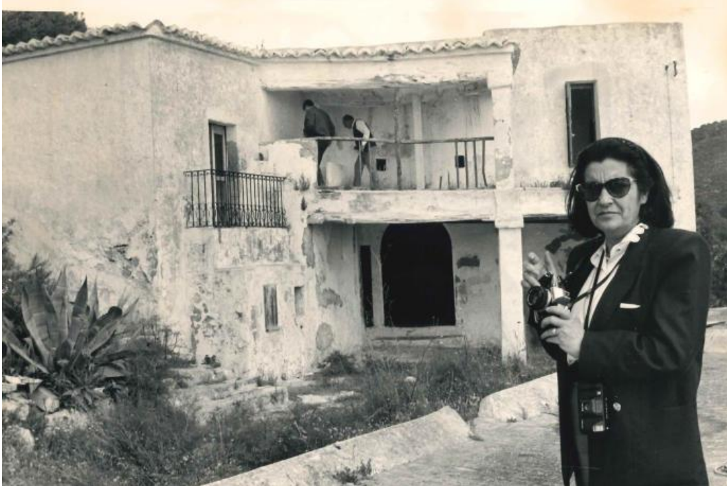
Figura 86. Exgerent de la Fundació Illes Balears durant la rehabilitació de Can Ros a Santa Eulària des Riu (Eivissa)
