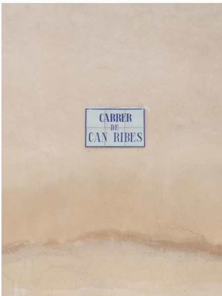
Figura 37. Carrer de Can Ribes. Font: elaboració pròpia.
