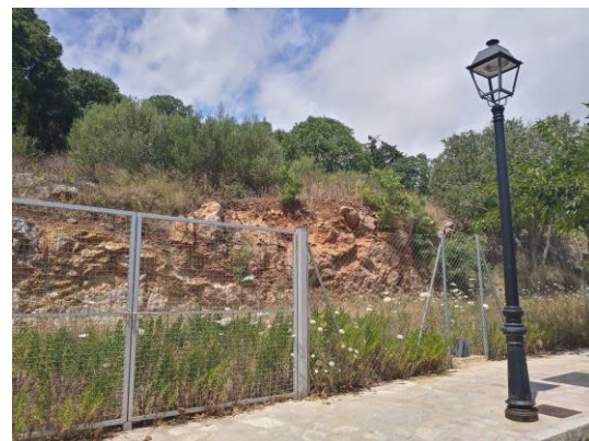
Figura 38. Carrer de Can Ribes. Font: elaboració pròpia.
