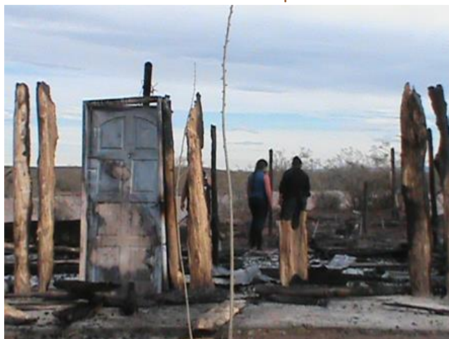
Figura 5. La puerta resiste al incendio y se transforma en el primer y último elemento de la casa desde un punto de vista simbólico
