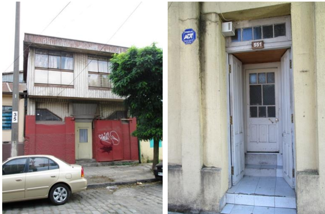
Figura 4. Las puertas reutilizadas se reajustan a la nueva estructura. Rozas 947 y en Prieto 551
