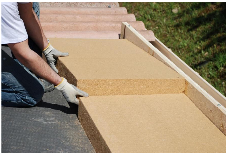
Ilustración 22. Muestra objetivo de viruta de madera compactada, con características y respuesta térmica conocida. Imagen propiedad de Socyr.
