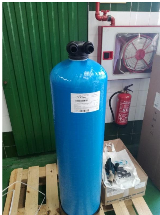
Figura.4.25. Columna de intercambio catiónico montada.
