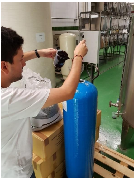
Figura 4.22. Adición de resina en el interior de la botella.
