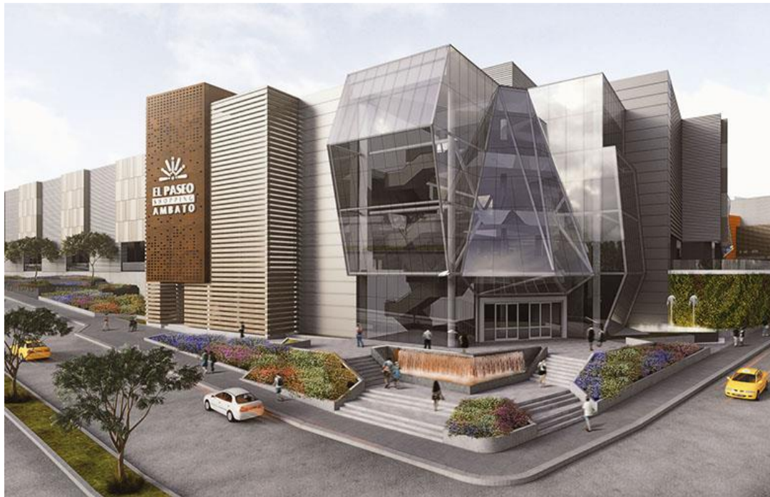
Figura 61. Centro Comercial El Paseo Shopping Ambato
