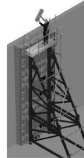
**Figura 18.4 : (4) Hormigonado de muros desde plataforma de hormigonado.**
