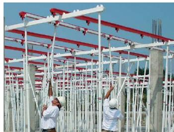
Figura 20.3: (2.3) Montaje de sopandas sobre las portasopandas.
