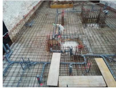
Figura 16.1: (2) Entablado de madera para circular por encima del armado. Fuente: Foto propia.
