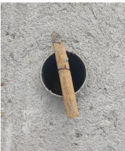
Figura 17.1: (1) Pasamuros tubo PVC de  $\varnothing 200\text{mm}$ . Fuente: Foto propia
