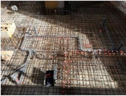
Figura 16.1: (1) Paso de instalaciones con tubería de PVC. Fuente: Foto propia.
