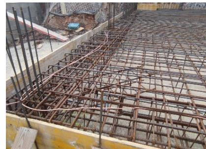
Figura 17.1: (3) cable trenzado desnudo de cobre de  $35\text{mm}^2$  de sección embebido en el perímetro de la cimentación. Fuente: Foto propia
