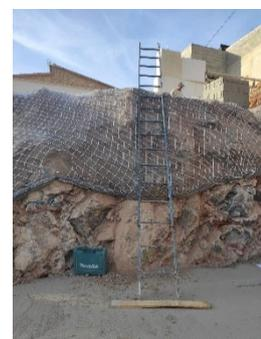
Figura 12: Ejm (2) Acceso excavación mediante escalera de mano.
