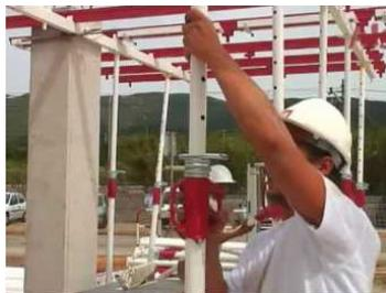
Figura 20.2: (2.1) y (2.2) Replanteo de portasopanda en pilar.
