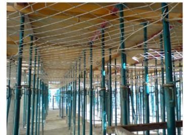
Figura 20.4: (2.4) Redes bajo forjado tipo B
