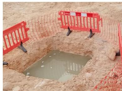
Figura 11: Ejm: (1) Barandillas móviles y malla de señalización.
