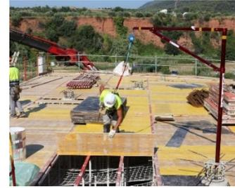
**Figura 20.5: (2.5) Colocación de tablero de encofrado**
