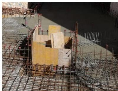
**Figura 15.2: (2) Encofrado por encima de la cimentación para evitar caídas a distinto nivel.**
