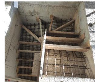
Figura: 22.3: Encofrado escalera.
