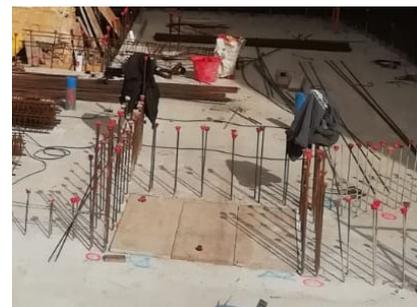
**Figura 15.3: (3) Tapado hueco foso ascensor + esperas arranque de muros.**
