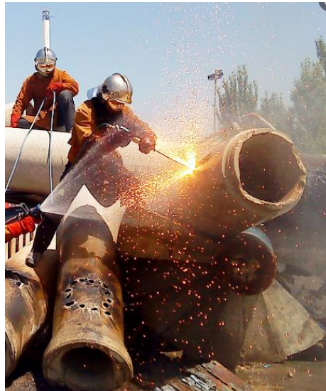
Ilustración 15: Corte por lanza térmica tubería
