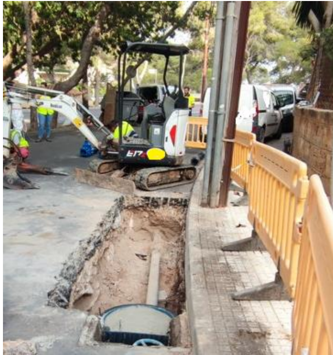
Ilustración 2: Apertura zanja hasta mostrar tubería
