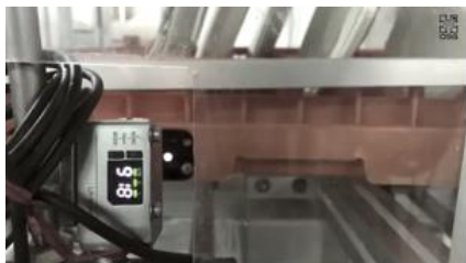
Figura 24: Sistema electrónico de control de la instalación
