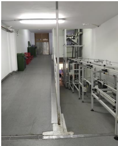
Figura 6: Rampa de Cocina a Restaurante Oliva
