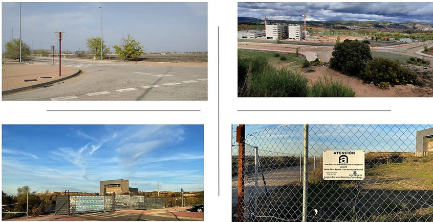
FIGURA 3 | Parcelas desocupadas del parque aeronáutico y logístico de Albacete (arriba izquierda), obras del hospital de Cuenca (arriba derecha) y abandono del Barrio Avanzado de Toledo (abajo)
