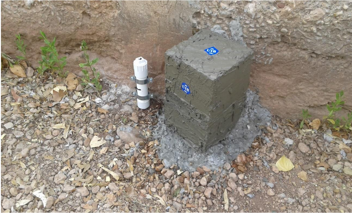
Figura 2. Sonda de pressió instal·lada al torrent de Ternelles.
