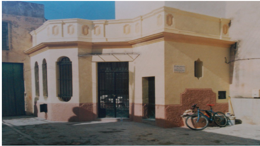
L'edifici de la Peixateria, al costat del qual s'hi ubica el Pou de na Xeruvia, a la Placeta des Peix.
