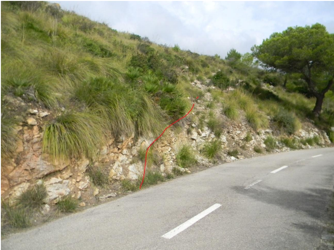
Imatge 57: Dolomies sobre fàcies maiòlica cretàiques. Ctra. Ermita Km.4,8
