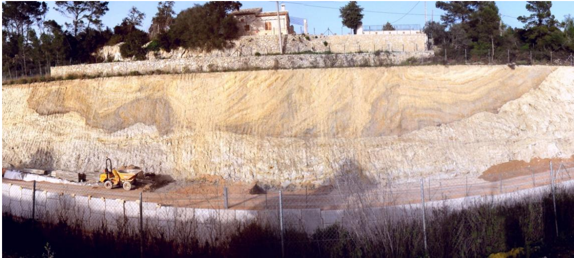
Imatge 33: Tall de la trinxera del ferrocarril Inca-Manacor al seu pas per Sineu. La base són turbidites burdigalianses i el sostre plegat margues lacustres oligocenes. Per evitar despreniments, l'aflorament actualment està sanejat i cobert. Fotografia de Borja López Rayo.
