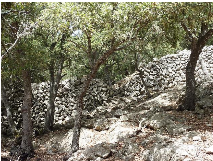
Exemple d'una paret de tancament, ubicada la zona de sa coma des Cairats. Font: www.airedelaserramallorquina.blogspot.com.es
