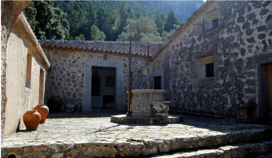
Cisterna de l'ermita de Valldemossa. Font: www.pmaria-valldemossa.org
