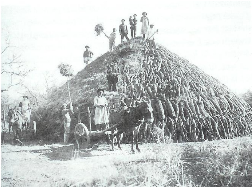
Imatge d'arxiu que mostra com es realitzava el muntatge de la sitja. Font: www.mestelrich2.blogspot.com.es
