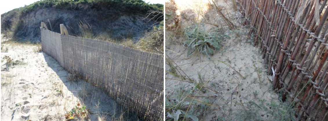
Figura 201: Imatges de detall de la trampa d'interferència sedimentària, i del baix grau d'eficiència mostrat a dia d'avui. Foto del 14/11/2013.
