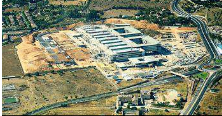
Figura 64: construcció de l'hospital de Son Espases
