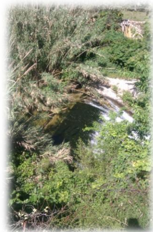
Ilustración 12; Presa de derivación.
