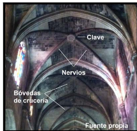
Ilustración 6 - Partes de la bóveda
