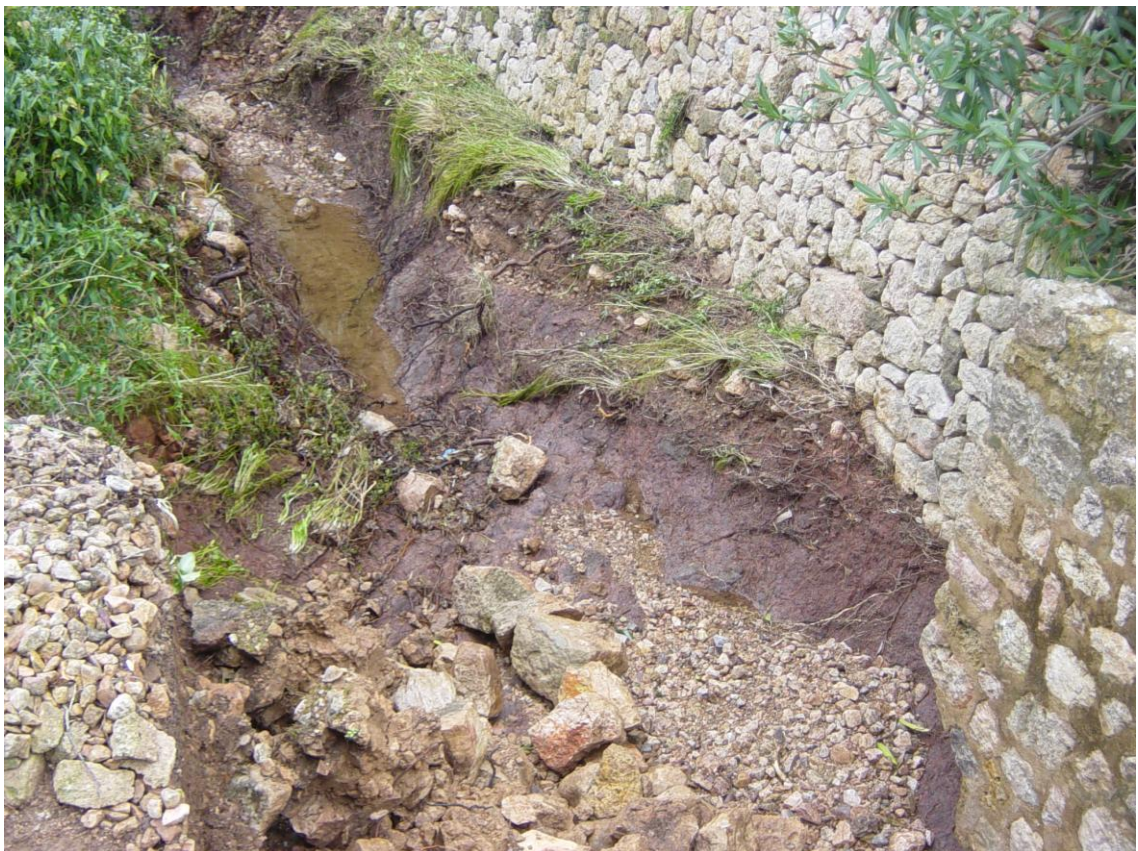
Figura 10.5 Marges erosionats i llit malmés al torrent de son Sales. Font: J. Rosselló.
