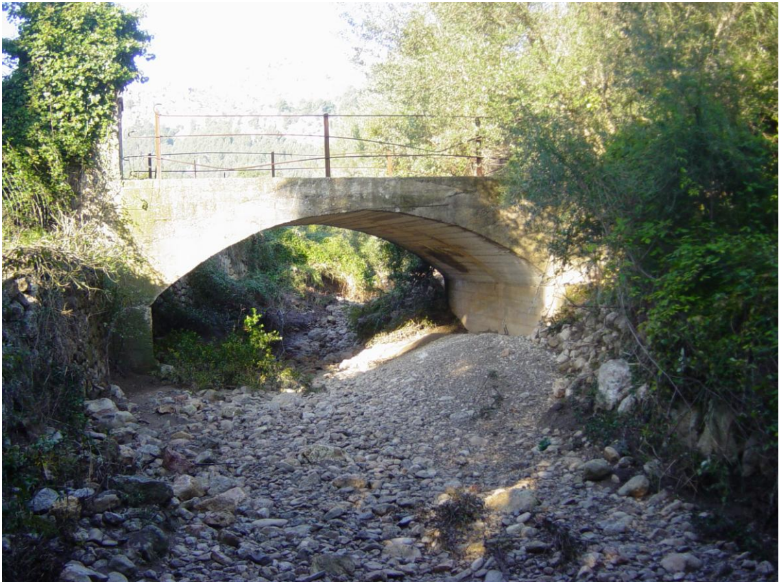
Figura 10.3 Pont de son Marc, superat per la torrentada de 2004 que danyà el camí a cada costat del pont. Font: M. Grimalt.
