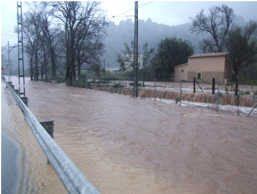
Figura 10.9 Desbordament del torrent Major a sa Cimentera. Font: J. Rosselló.
